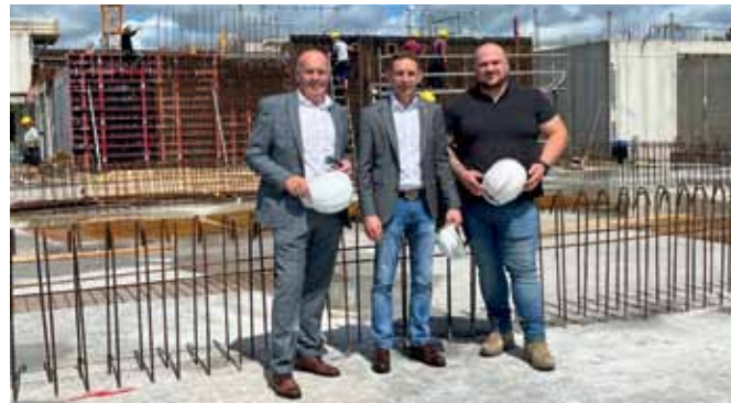
Bildungscampus - alles im Plan. Die Arbeiten für die neue Volksschule und die Räumlichkeiten für die Zentralmusikschule und die Stadtkapelle laufen nach Plan. Davon konnte sich Bürgermeister Georg Rosner bei einem Rundgang auf der Baustelle selbst überzeugen.
