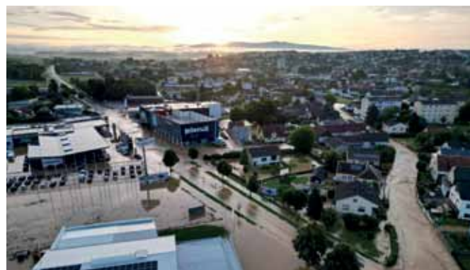
In der Nacht auf den 9. Juni wurden die Bürger von Oberwart und St. Martin/Wart vom Wasser überrascht, viele Keller und Häuser waren betroffen. Bilder: Husbauer, Stadtfeuerwehr und privat
