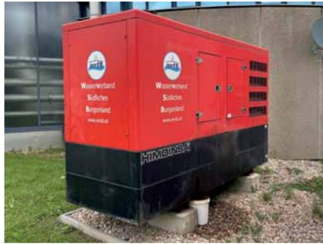
Notstromaggregat. Die Wasserwerke Oberwart und Pinkafeld wurden mit Notstromanlagen ausgestattet. Bild: WWSB
