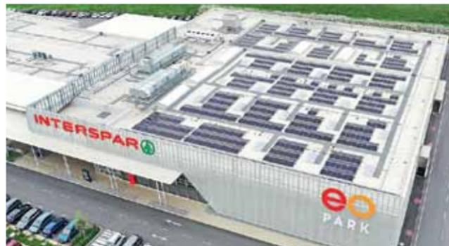
**Sonnenenergie.** Insgesamt 244.000 kWh erzeugt die neue Photovoltaikanlage am Dach des Interspar-Hypermarkts. Foto: Interspar/PVI
