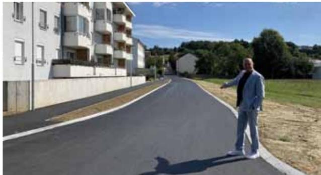
**Semmelweisgasse saniert** Die Arbeiten für den ersten Bauabschnitt der Semmelweisgasse konnten erfolgreich abgeschlossen werden. Im Zuge des Projektes wurden der Regenwasserkanal, die Wasserleitung, die Straßenbeleuchtung und die Fahrbahn erneuert.
