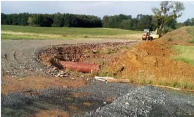
*Hangwasserschutz. Die Arbeiten für den ersten Teil konnten mittlerweile abgeschlossen werden. Ein Damm wurde aufgeschüttet und mittels Drosselabfluss wird das Wasser abgeleitet. Die Arbeiten für den 2. Teil des Hangwasserschutzes sollen 2021 beginnen.*
